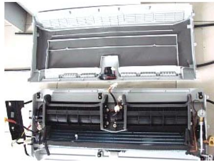
2.4、拔下蒸发器开关插头。
